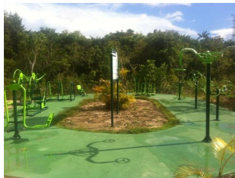
Equipamentos Instalados Parque Sumáuma - Manaus AM
